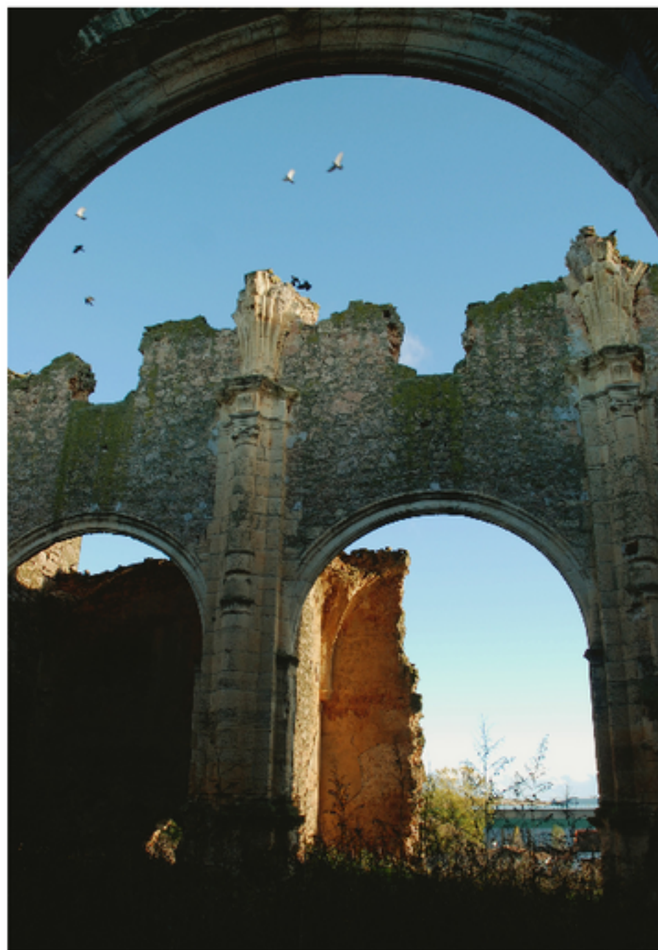
Interior de las ruinas del Convento.
