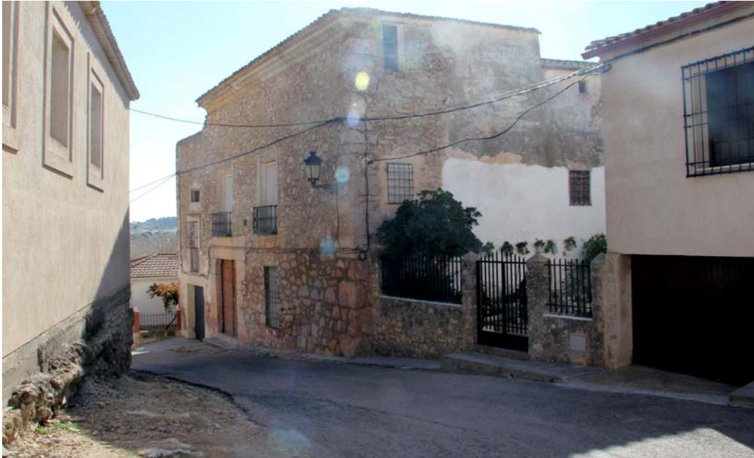
Figura 30. Acerado insuficiente o inexistente. Pavimentación inadecuada. Desniveles excesivos. Falta de protección
