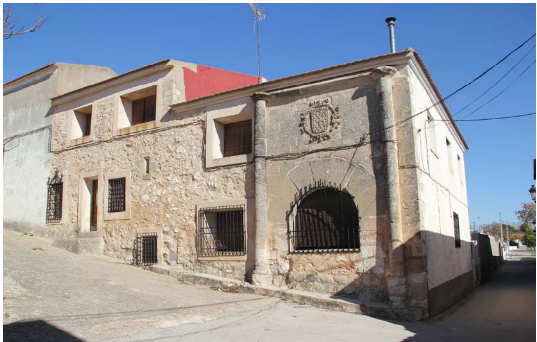
Figura 33. Pendiente excesiva. Falta de protección en desniveles. Ocupación de tránsito por acceso a la edificación
