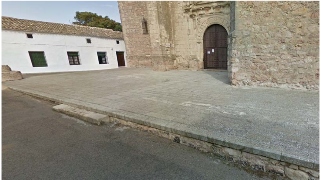
Figura 35. DCU4 (Iglesia Parroquial): desniveles sin barrera de protección; escalones en acceso
