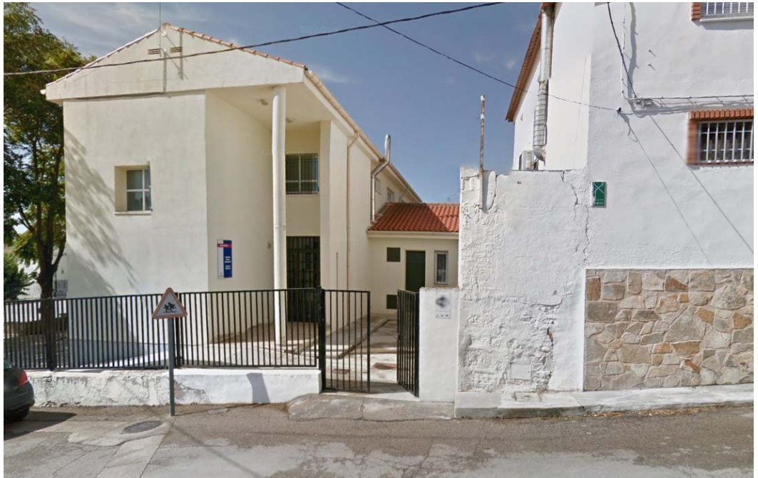
Figura 36. DEDU (Colegio): acerado insuficiente; desnivel excesivo en acceso; ocupación del tránsito peatonal
